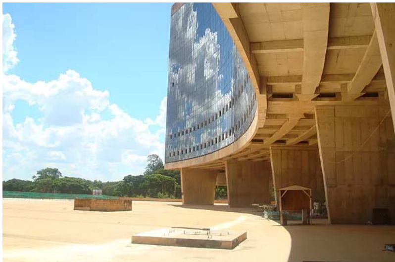
Nova sede do TRF1 em construção
